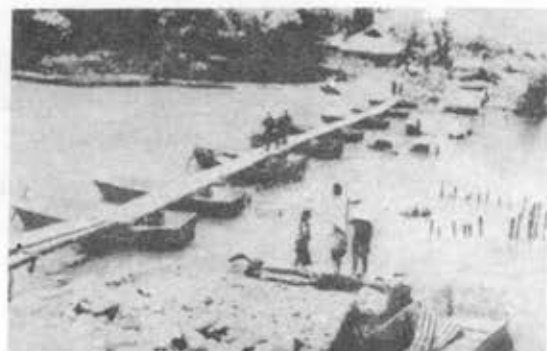
Một cây cầu nổi bằng xúng M2.
