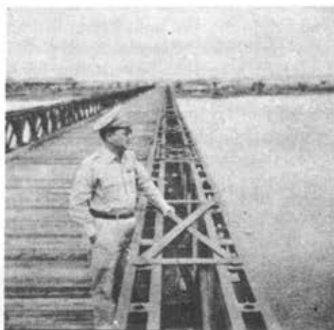
Cây cầu Hiền Lương với sườn sắt lát gỗ.
