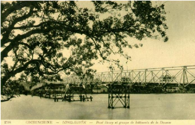
2718 COCHINCHINE — LONG-XUYEN — Pont lévy et groupe de bâtiments de la Douane
